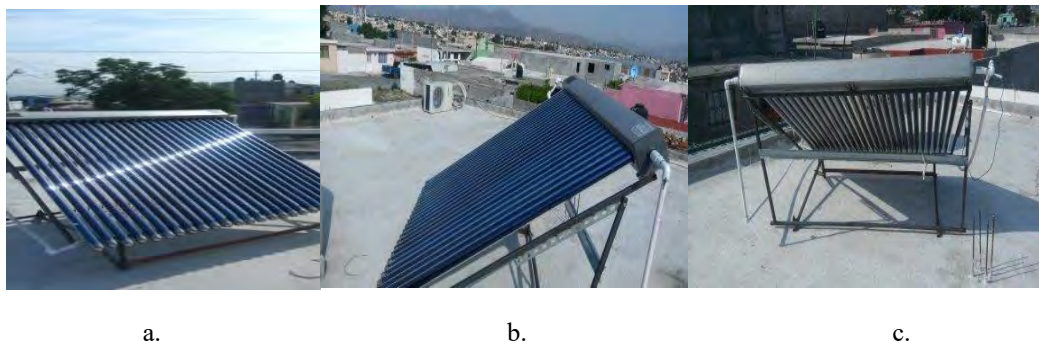
Figura (1). Vistas de instalación de panel solar (a, b, c).
