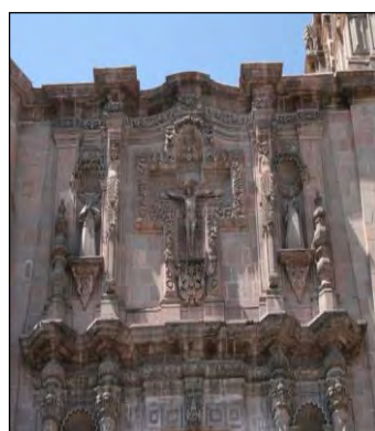
Fig. 3. Tercer Nivel de Fachada
