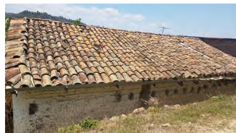
Imágenes 4 y 5. Cubiertas de madera y teja. Fotografías: Norma Leonor Valdés Sosa
