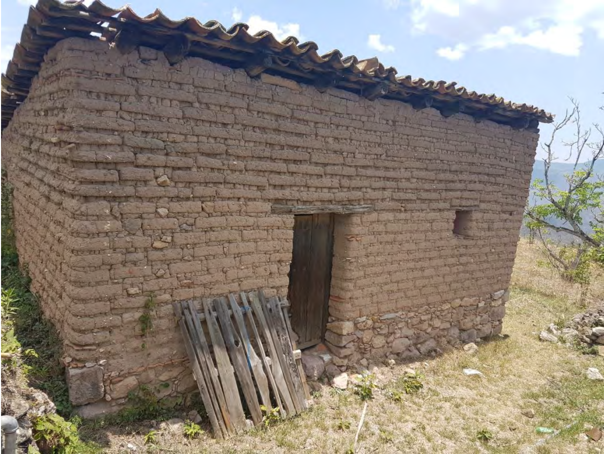
Imagen 3. Muros de adobe. Fotografía: Norma Leonor Valdés Sosa
