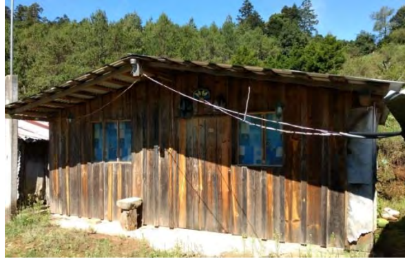
Imágenes 6 y 7. Muros de morillo y muros de tablas. Fotografías: Norma Leonor Valdés Sosa
