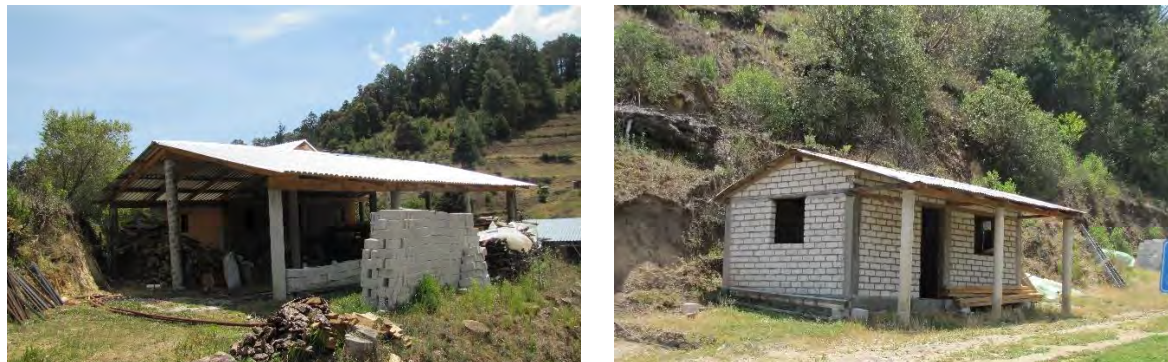
Imágenes 9 y 10. Casas de ladrillo de cemento, concreto armado y lámina. Fotografía: Carlos Ramírez Montes
