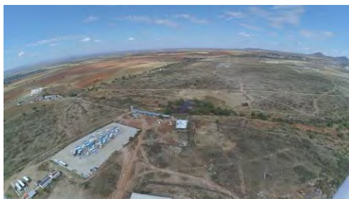
Figura 7. Fotografía tomada desde el dron modificado.
