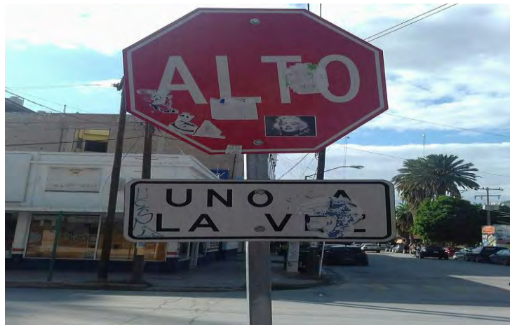
Fig.2 Señales de tránsito en mal estado en las principales calles de la ciudad.
