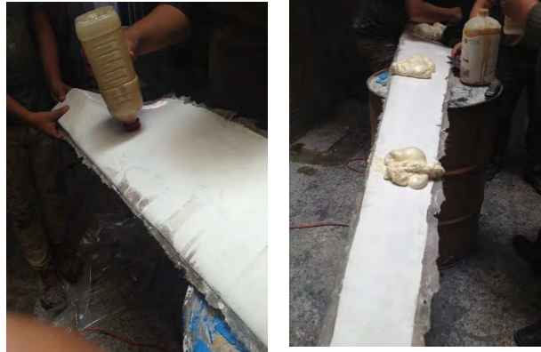
Figura 3.2.11 Inyección del Poliuretano.
