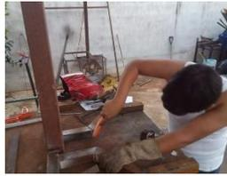
Figura 7. Limpiando el exceso de soldadura
