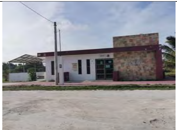
Figura 7. Nuevo y renovado Centro de Salud.
