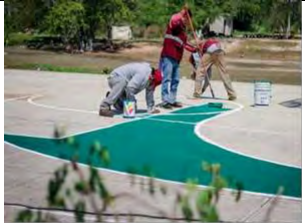
Figura 5. Estado actual de la cancha de basquetbol.
