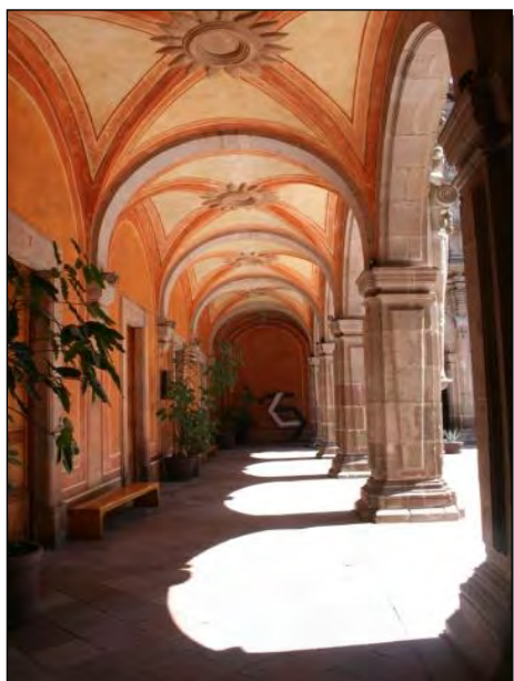
Fig.8 . Bóvedas de arista en corredor inferior
