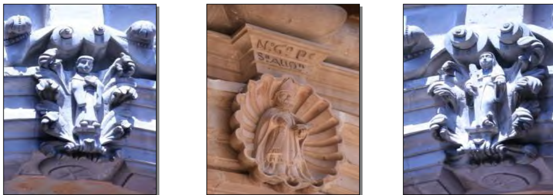
Fig.7 . Claves de arcos de medio punto en el patio central
