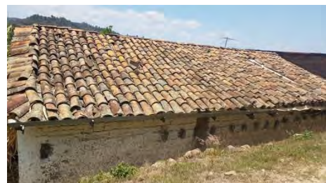
Imágenes 4 y 5. Cubiertas de madera y teja. Fotografías: Norma Leonor Valdés Sosa
