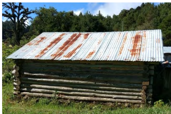
Imágenes 6 y 7. Muros de morillo y muros de tablas. Fotografías: Norma Leonor Valdés Sosa
