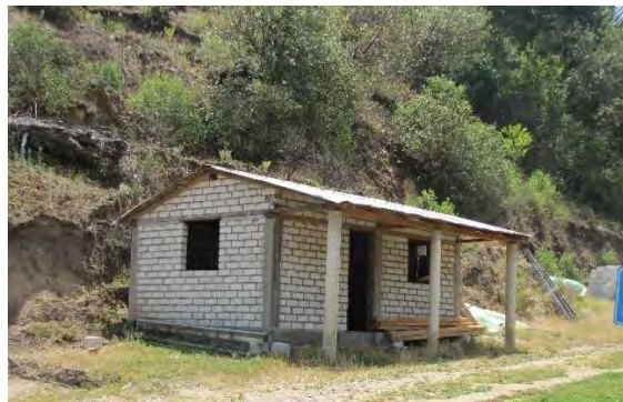
Imágenes 9 y 10. Casas de ladrillo de cemento, concreto armado y lámina. Fotografía: Carlos Ramírez Montes
