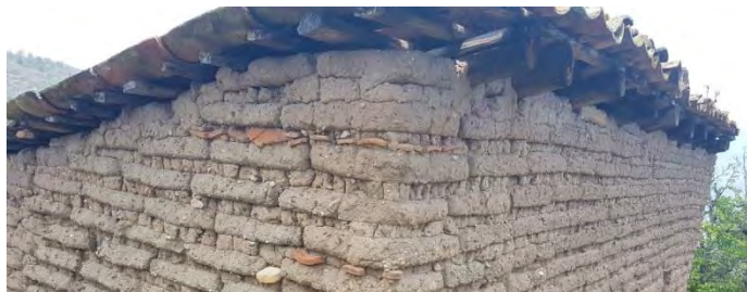
Imágenes 4 y 5. Cubiertas de madera y teja. Fotografías: Norma Leonor Valdés Sosa
