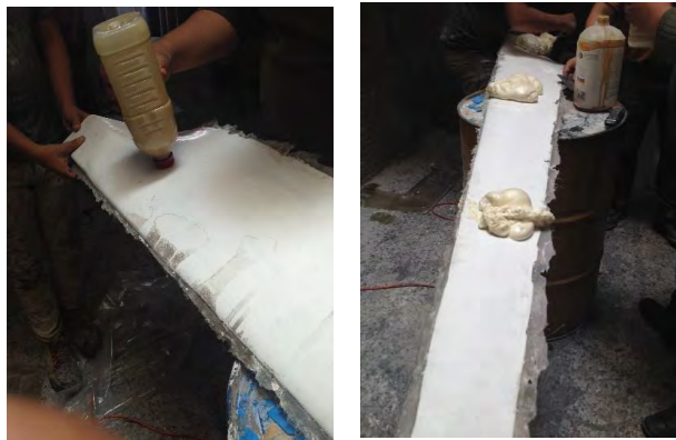
Figura 3.2.11 Inyección del Poliuretano.
