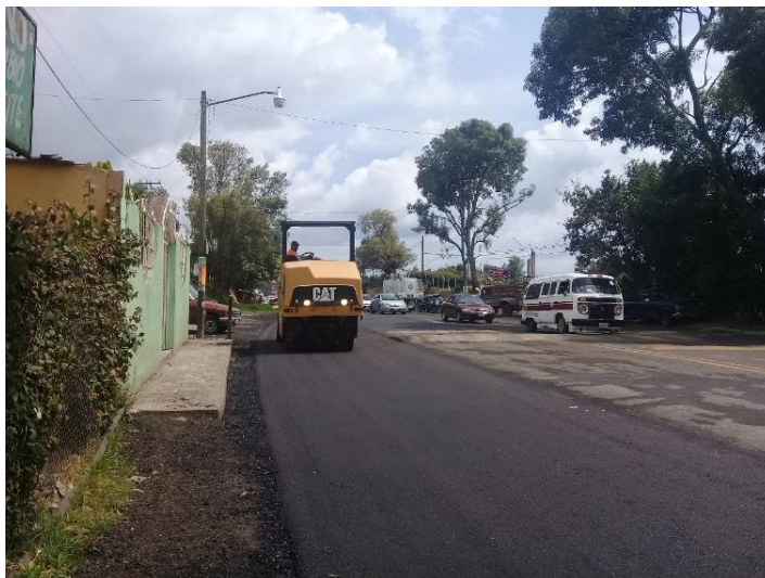
Imagen 2 tramo carretero después del reencarpetaamiento
