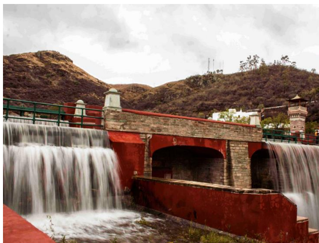
Imagen 1. Apertura de la Presa de la Olla
