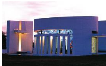
Figura 8. Capilla, Universidad La Salle, Ciudad Obregón, Sonora, México. Arq. Oscar Castro del Valle
