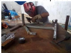
Figura 6. Aplicando la soldadura y el perfil ya soldado
