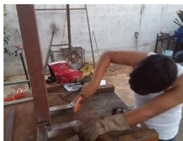
Figura 7. Limpiando el exceso de soldadura
