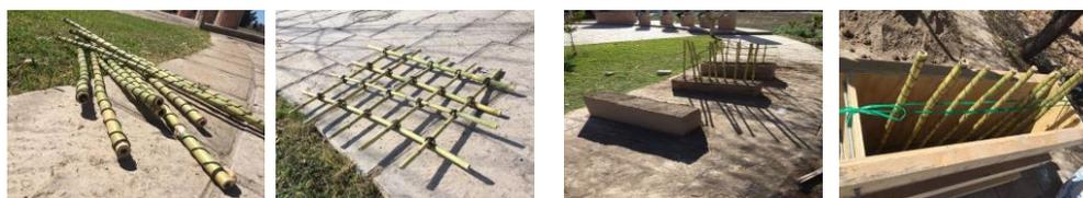
Figura 3. Corrugado en carrizo, diferencias de armado y colocación de refuerzo.
