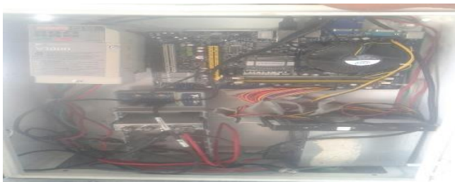
Instalación del control para el motor trifásico y los sistemas de protección
