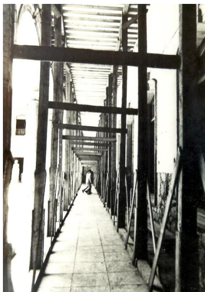
Figura 04. Trabajos de restauración, Archivo Fidel Fabián.
