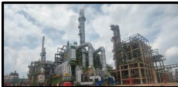
Figura 1 Planta Combinada Maya Refinería General Lázaro Cárdenas
