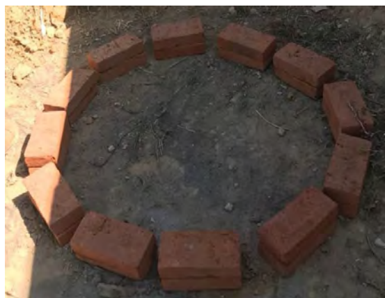
Figura 5. Ladrillos para la base del tinaco
