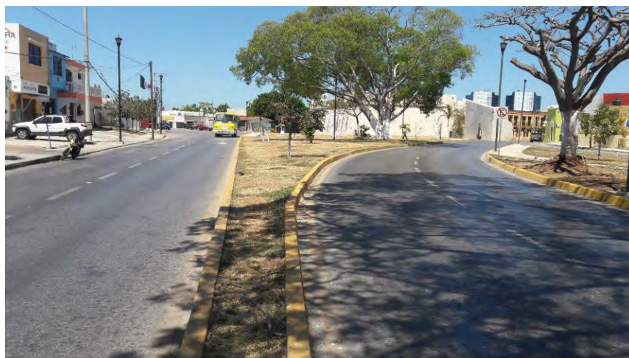
Figura 1. Vialidad circundante al Baluarte Santa Rosa Fuente: Propia (2018).
