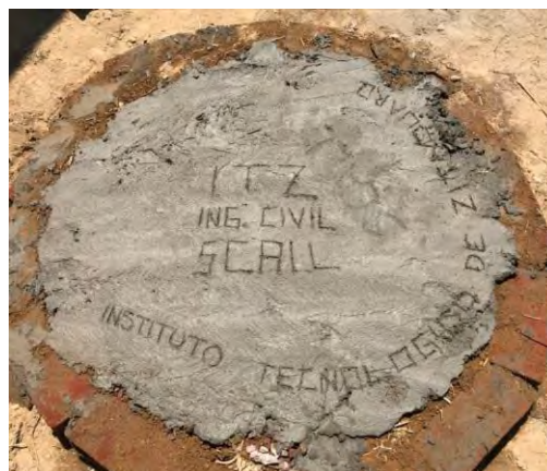
Figura 6. Base ya con mortero
