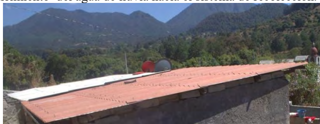
Figura 2. Área de captación de la casa
