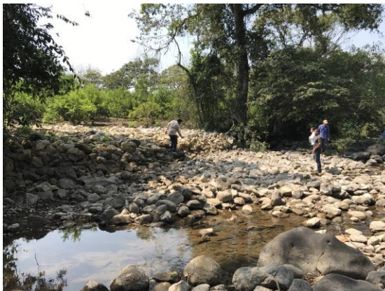
Fotografía 4. Relleno del socavón principal
