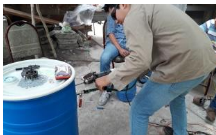
Figura 1. Orificios realizados en el tambor de polietileno
