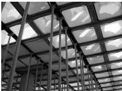
Fig 4. Naturaleza de puntales en cimbra de losas
