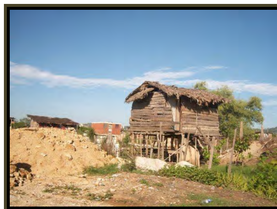
Figura 5. Foto de vivienda mitigando el riesgo.
