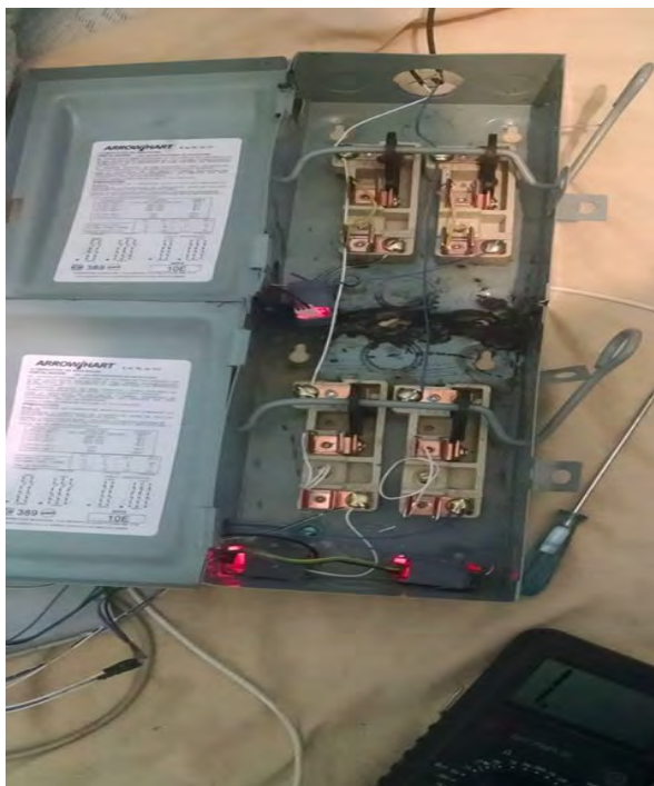
Figura 4. Muestra la conexión de los componentes del robot suministrador de energía.
