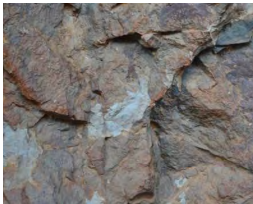
Foto 2.- Inyección de cal para evitar desprendimiento. foto Jorge Porras Allende
