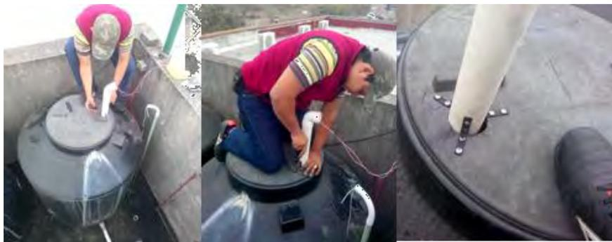
**Fig. 11. Colocación física de tubo con sensores de nivel**
