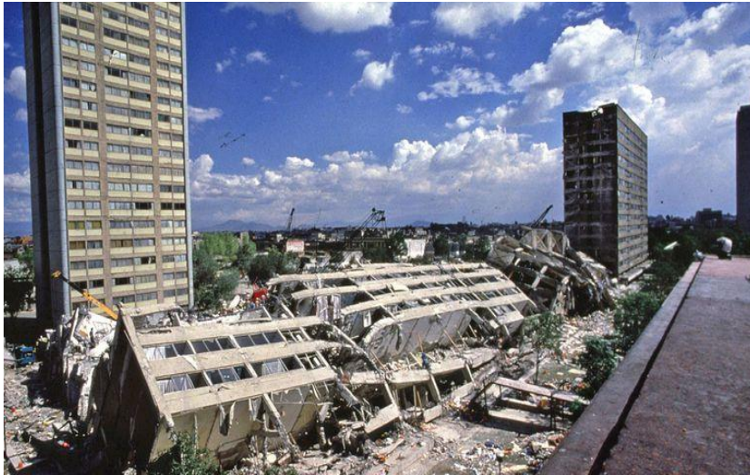
Figura 8: Foto en la que se muestran los daños diferenciados que deja un terremoto en los alrededores dependiendo del tipo de construcción. El edificio Nuevo León se destruyó por completo y el Veracruz no sufrió daños. ¿Frecuencias naturales diferentes o deficiencias en su construcción?
