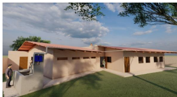
Imagen 11. Fachada posterior de la Unidad de Salud
