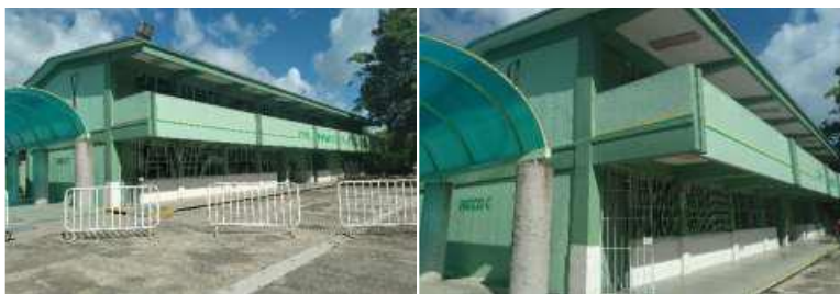
Figura 1.- Edificio C del TecNM-ITVH.
