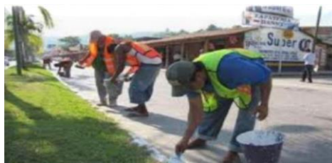
Figura No. 1 Pintura de calzada
