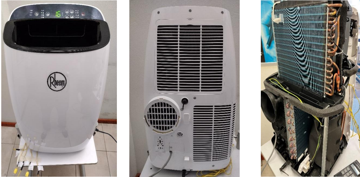
Fig. 1.- Sistema de aire acondicionado portátil, (a) frontal, (b) trasera, (c) sin cubiertas.
