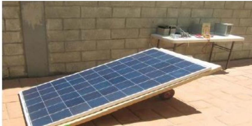
Figura No.9 Conexión de la alimentación externa diseñada mediante panel solar a la fuente de UTR
