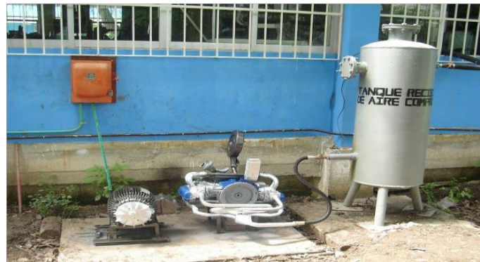
Figura 2. Sistema de Suministro de Aire Comprimido
