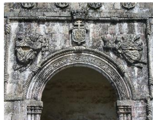
Fig 5. 2ª. Capilla Posa
