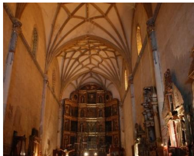
Figura 10. Nave Central del templo
