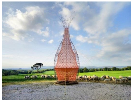
Figura 1. Torre Warka Water de Arturo Vittori, construida Dorza, Etiopía en 2015.
