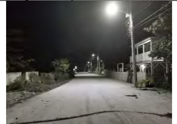
Figura 9. Estado actual del servicio de alumbrado público.
