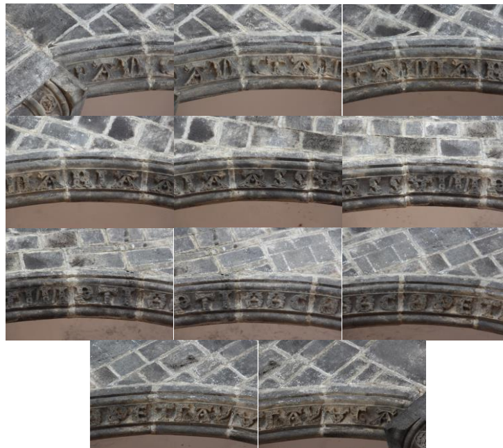
Figura 9. Dovelas del Arco de la Capilla Abierta
