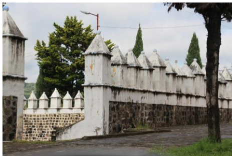
Figura 7. Atrio. Almenado Exterior e Interior
