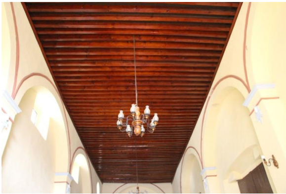
Figura 14. Artesonado de la Nave de la Capilla
