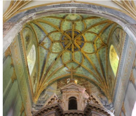
Figura 19. Ábside con Bóveda de Crucería
