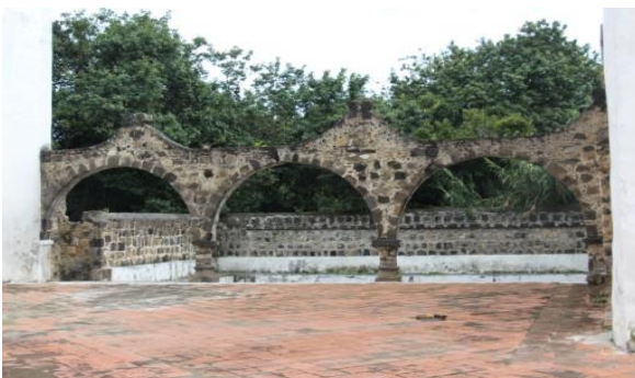
Figura 5. Aljibe y Cisterna en el Exconvento
