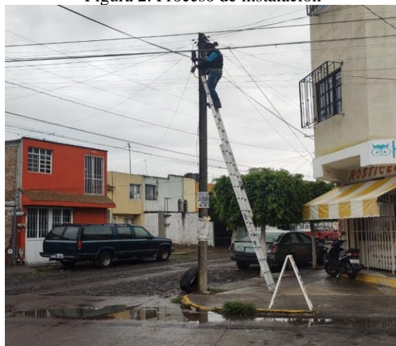
Figura 2. Proceso de instalación
