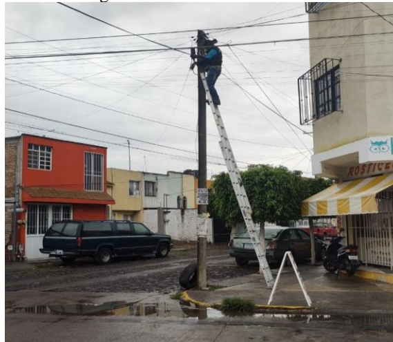
Figura 2. Proceso de instalación
