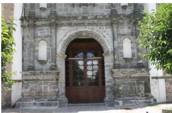
Figura 3. Primer Nivel de la Fachada del Templo
