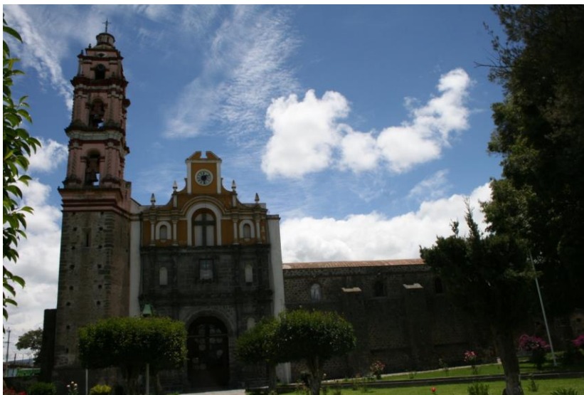
Figura 2. Fachada del Templo y ex convento en Santa Cruz, Tlaxcala
