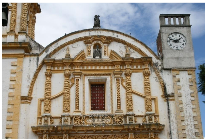
Figura 13. Segundo nivel de la fachada
