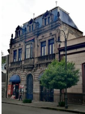
Figura 4. "Casa Pliego" Obra de Charles H. Hall. (Propia, 2021).
