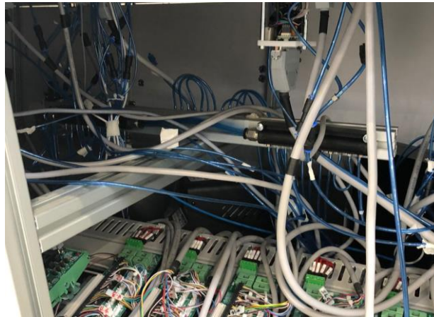
Figura 5. Cableado de sistema eléctrico y neumático.
