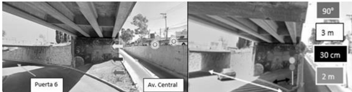
Figuras 8. Ubicación y dimensiones del semáforo de alerta.
