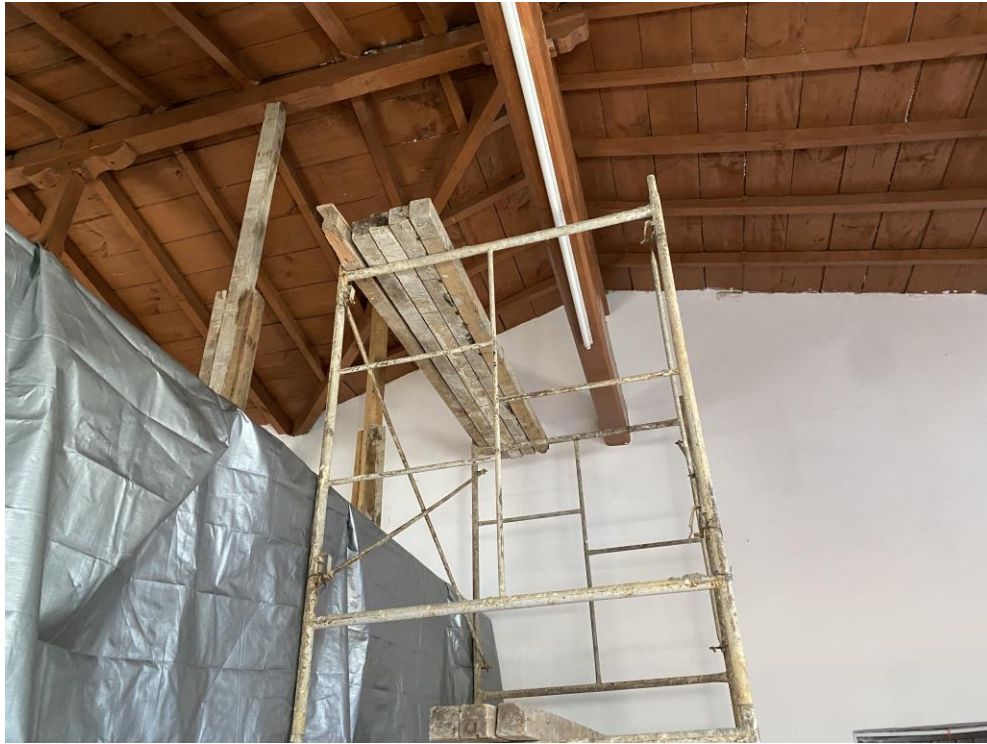
Imagen 4. Vista interior de la cubierta Fuente: Propia RMMA 2022
