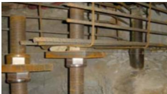
Figura 1._ Elementos de acero soldados a la barra de refuerzo
