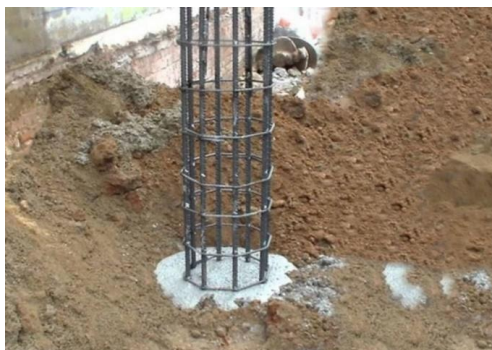
Figura 5. _ Pilote colado en el sitio, con diámetro de 30 cm, 20 m de longitud y f'c de 250 kg/cm 2
