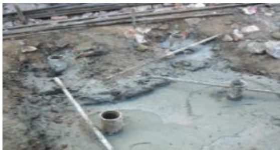
Figura 6. _ Pilotes con cimbra de tubo PVC rígido, 15 cm de diámetro 6 m de largo
