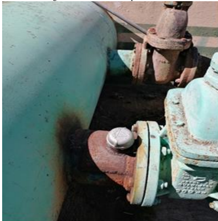
Figura 4: Corte del tramo corroído y unión de cople mediante soldadura.
