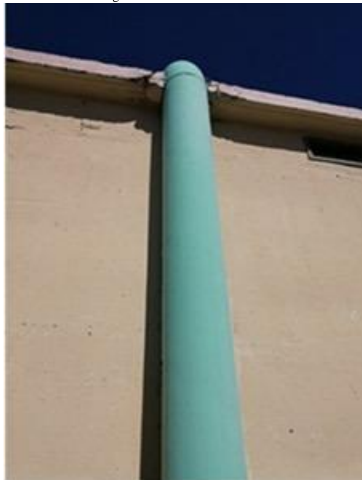
Figura 6: Resanado de tubería.
