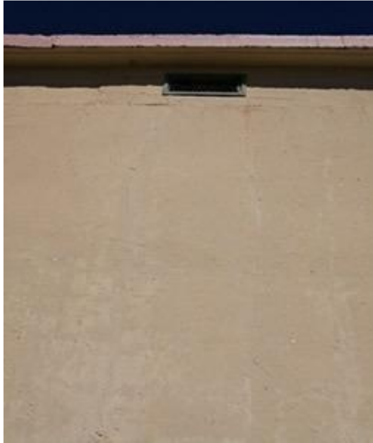
Figura 7: Resanado de pared en tanque de almacenamiento de la normal.
