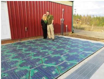
Figura 3. Panel solar como piso exterior. Alvarado Ternes
