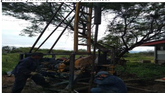
Imagen 1. Realización de la prueba de penetración estándar.
